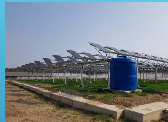
집수 Tank 5 ton
